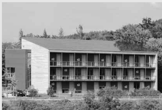
Marché International, Kemptthal, Nullenergie-Bürohaus von Architekt Beat Kämpfen
